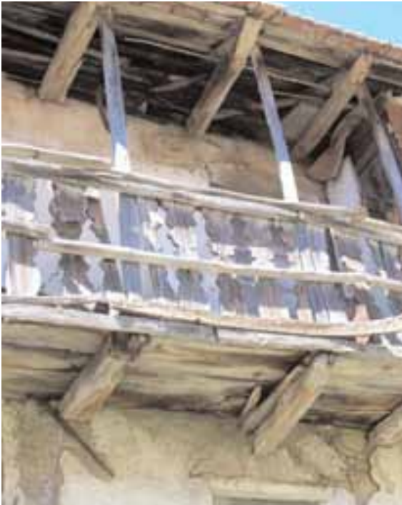
Gli elementi costruttivi - i ballatoi
